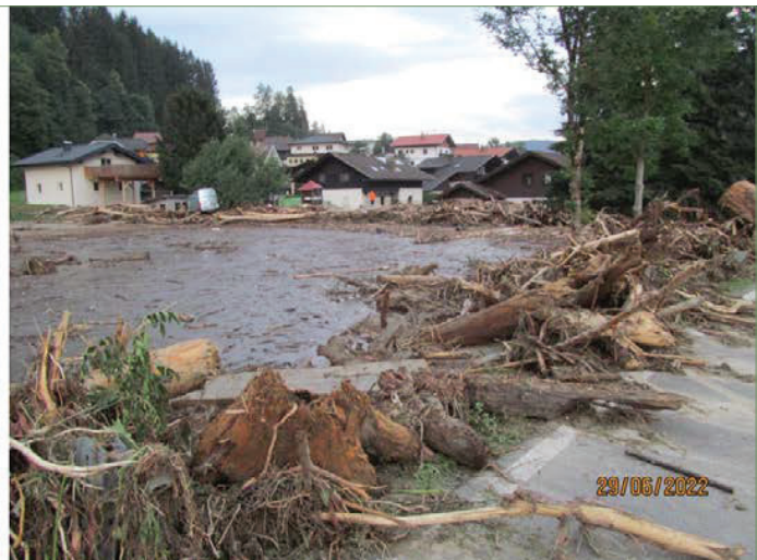
Dammbruch bei Waidegg beim Gailhochwasser Oktober 2018 (links), Feststoffablagerungen im Bereich der Vogelsangssiedlung nach dem Hochwasser im Ggendtal Juni 2022 (rechts)
